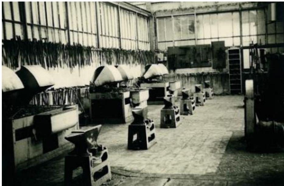
Lycée de Creil Rue de Gournay Atelier de Forge , Zone Forge Libre en 1965
